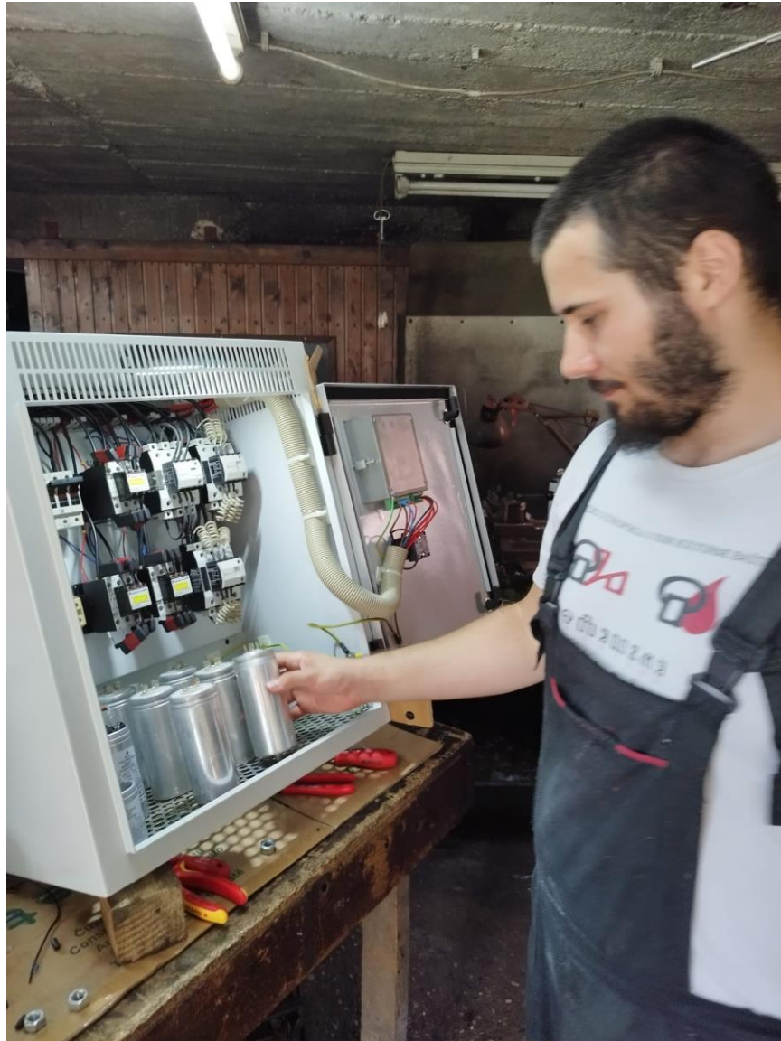
Slika 4.15 Ugradnja kondenzatorskih baterija
