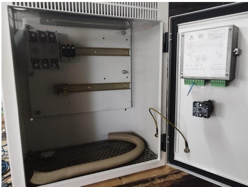
Slika 4.10 Ugradnja prihvatne ploče sa ostalim montažnim elementima
