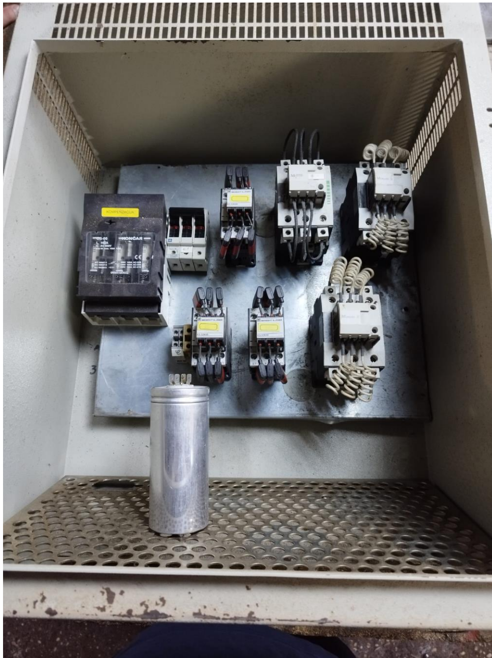
Slika 4.7 Postavljanje komponenti u ormar i planiranje rasporeda
