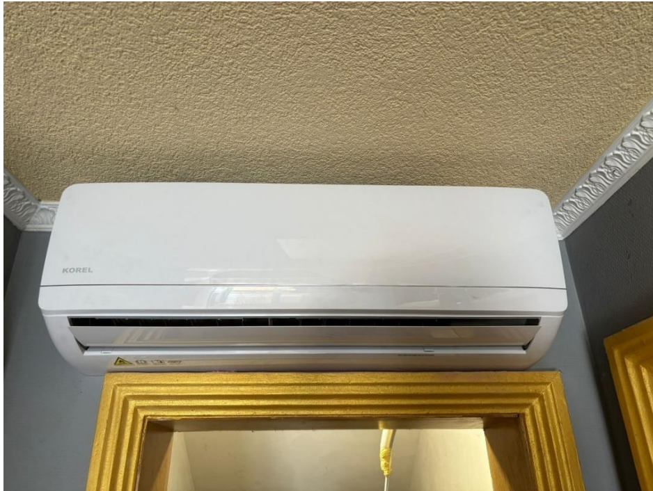
Slika 6.3. Montaža unutarnje jedinice.
