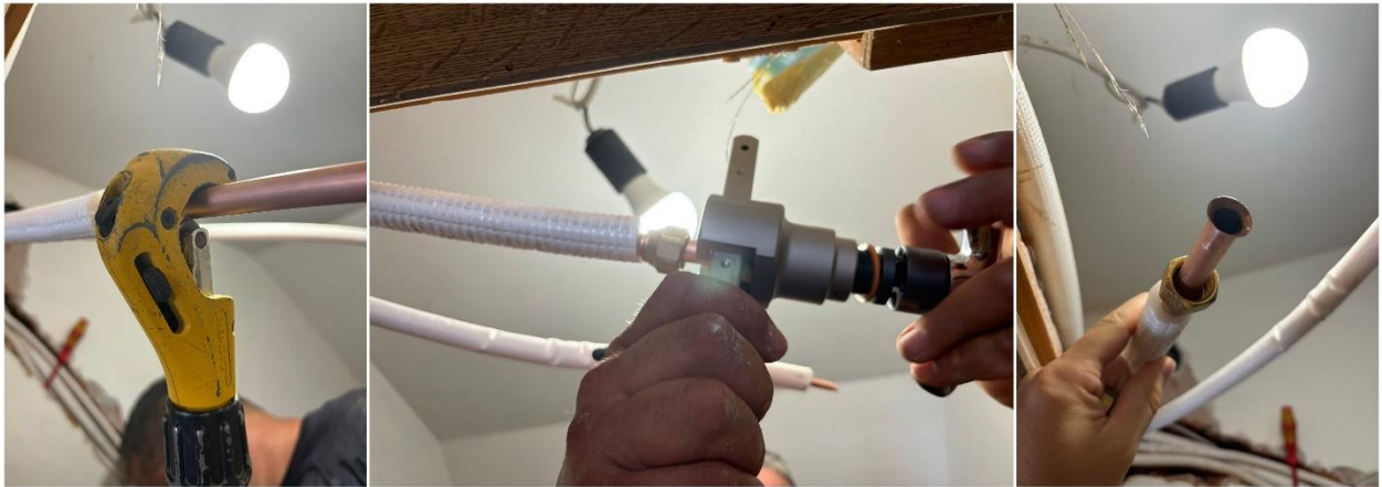
Slika 6.4. Priprema krajeva bakrenih cijevi za spajanje na cijevi unutarnje jedinice.
