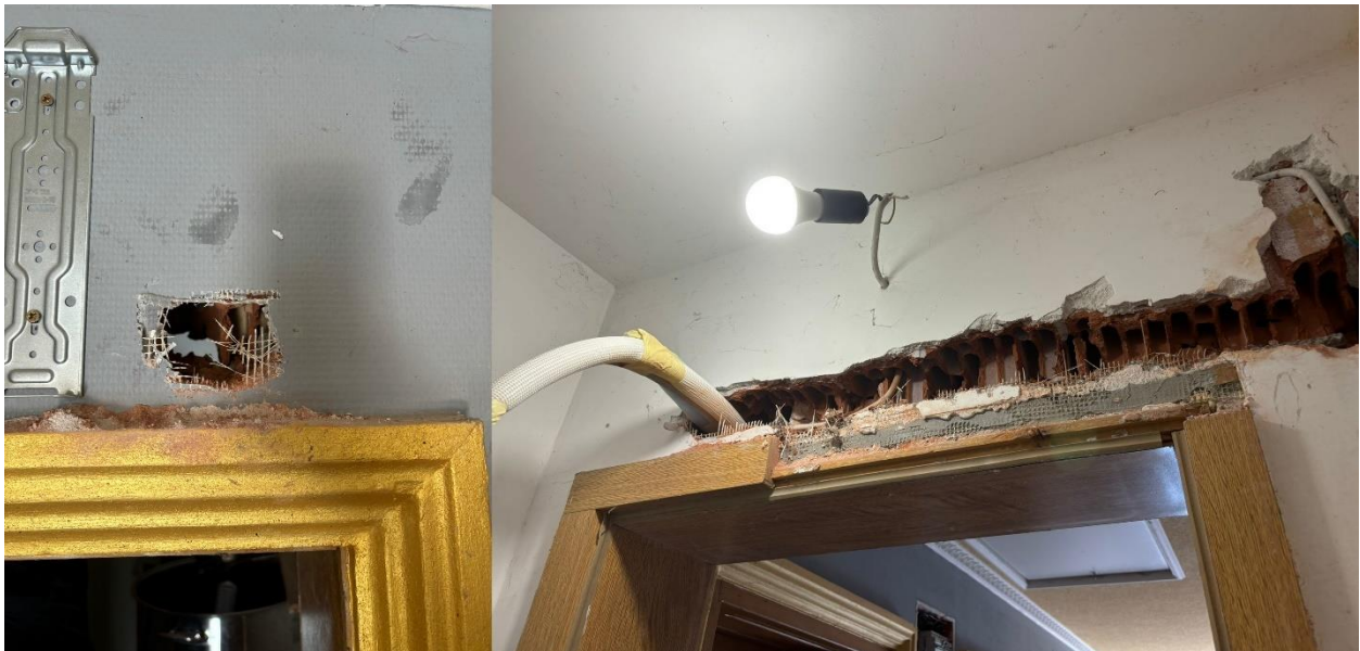
Slika 6.2. Bušenje rupe za cijev klima uređaja.
