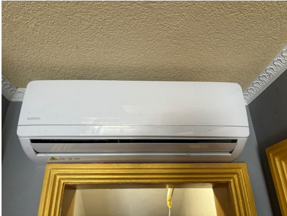
Slika 6.3. Montaža unutarnje jedinice.
