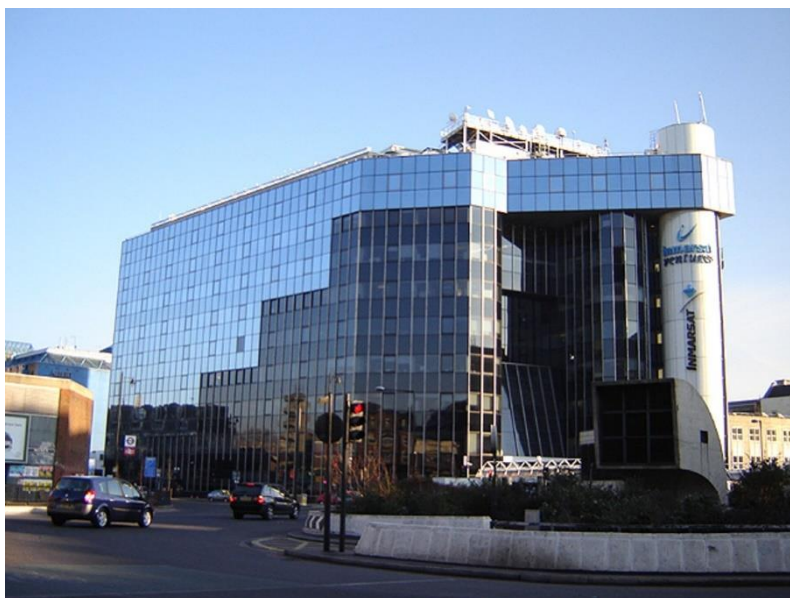
Slika 3.1. Zgrada Inmarsat-a u Londonu [9]
