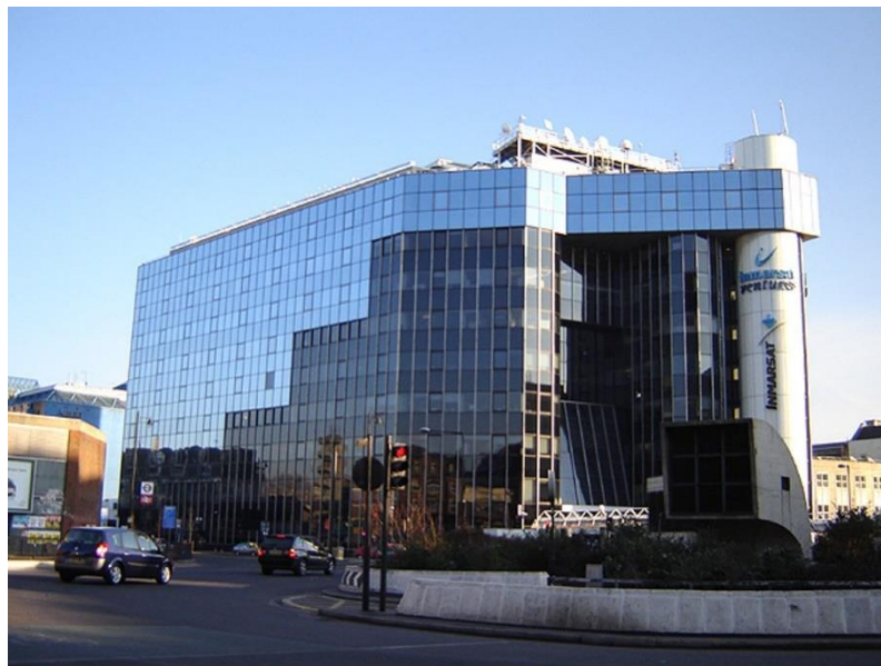
Slika 3.1. Zgrada Inmarsat-a u Londonu [9]
