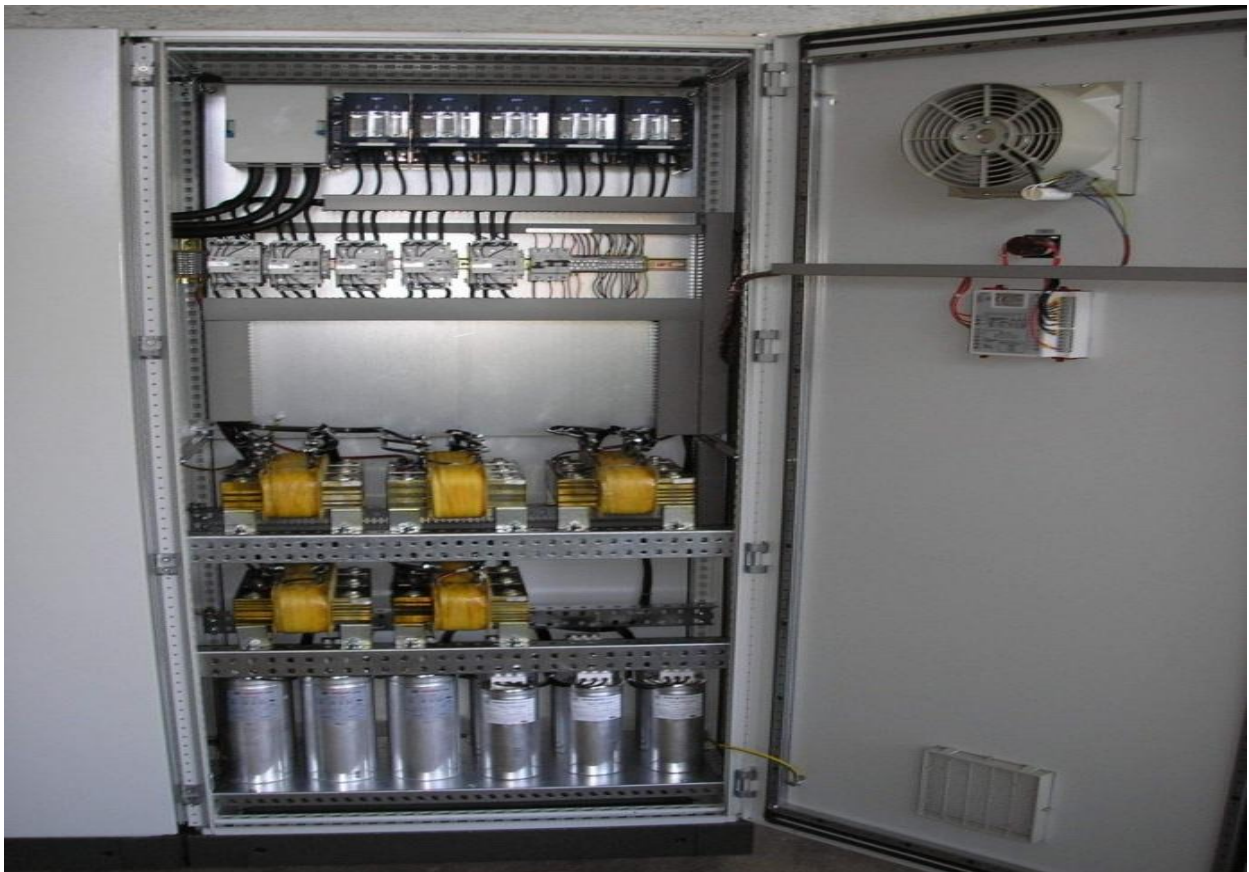
Slika 5.3. Uređaj za kompenzaciju jalove snage
