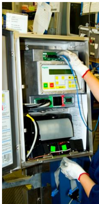
Slika 5-6 Primjer spajanja na upravljački ormarić
