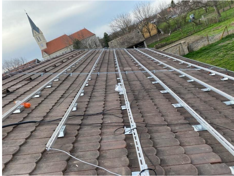
Slika 3.4 Prikaz postavljanja pod konstrukcije na krov
