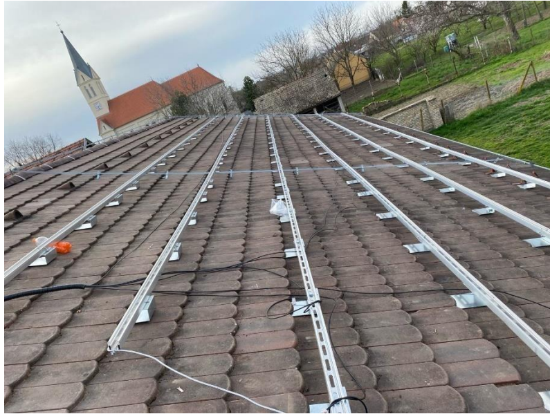
Slika 3.4 Prikaz postavljanja pod konstrukcije na krov
