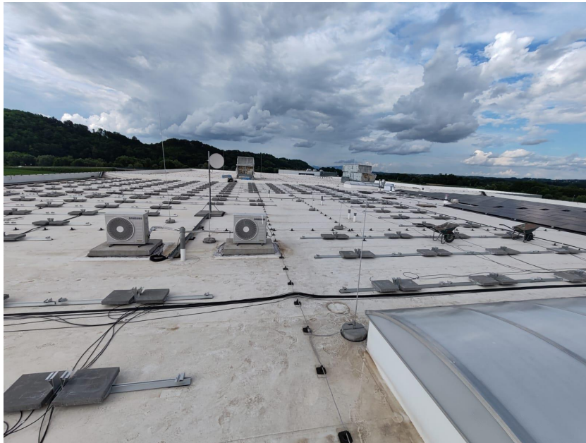
Slika 3.8 Prikaz postavljene podkonstrukcije za fotonaponskih modula na ravnom krovu
