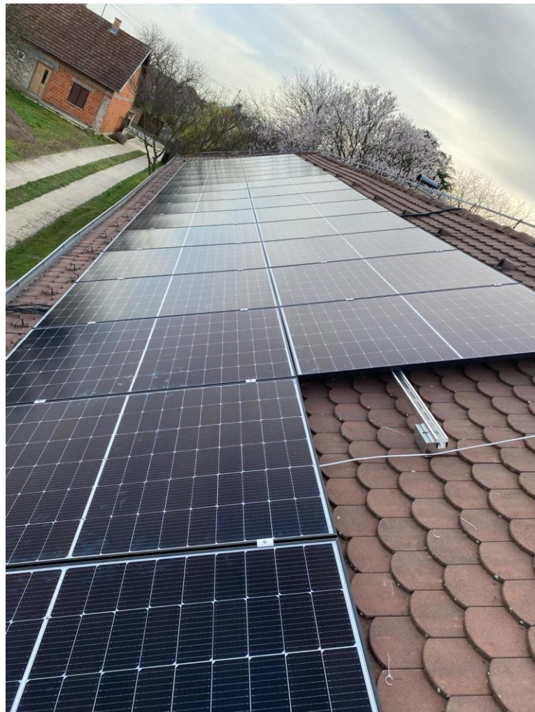
Slika 3.5 Prikaz postavljenih fotonaponskih modula na krov
