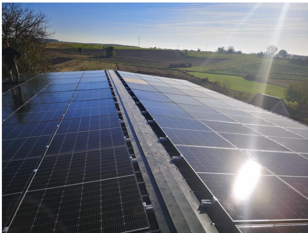
Slika 3.7 Prikaz postavljene fotonaponskih modula za trapezni lim
