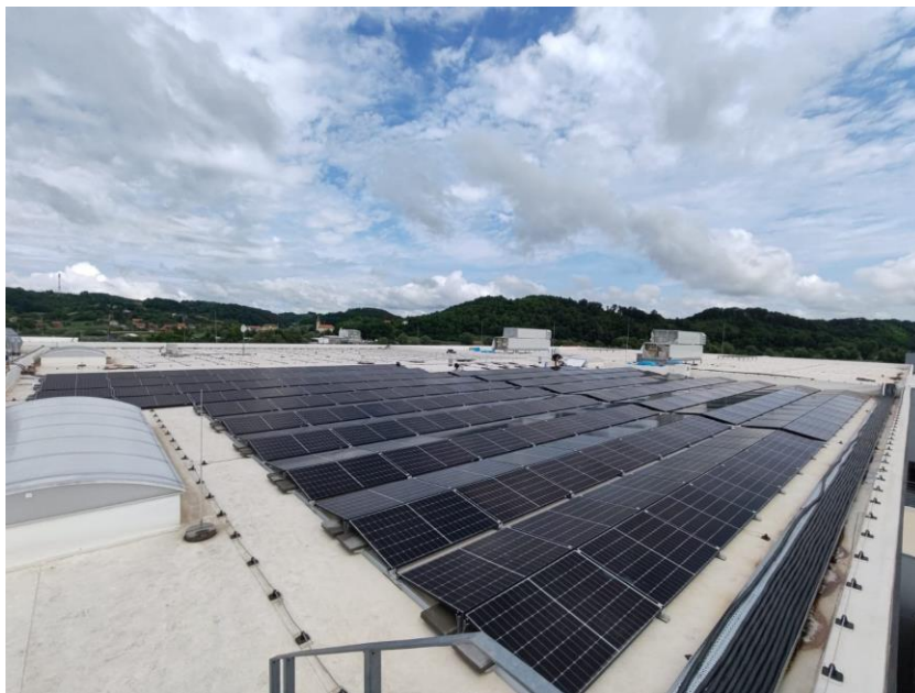
Slika 3.9 Prikaz postavljene fotonaponskih modula na ravnom krovu
