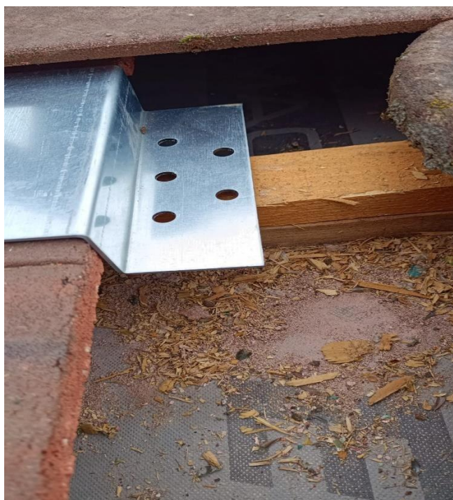
Slika 3.2 Prikaz postavljanja kuka na rog
