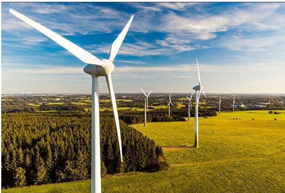
Slika 3.3 Vjetroturbina sa horizontalnom osi [28]
