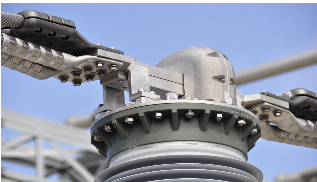
Slika 5.1.: Optički strujni mjerni transformator Trench [7]
