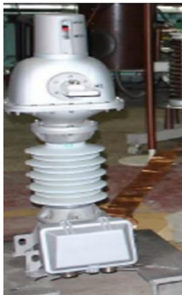
Slika 3.1.: Mjerni transformator AGU-38 [21]
