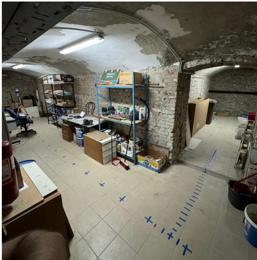
Slika 4.5 Podrum FERIT-a u kojem su provedena mjerenja
