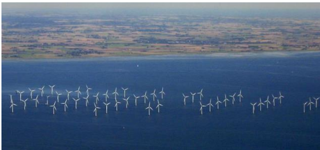
SI.3.2. Priobalna vjetroelektrana Lillgrund (Švedska) puštena u pogon 2008. Koristi 48 vjetroagregata SWT 2.3-93. Električnom energijom opskrbljuje 60 tisuća kućanstava.[8]
