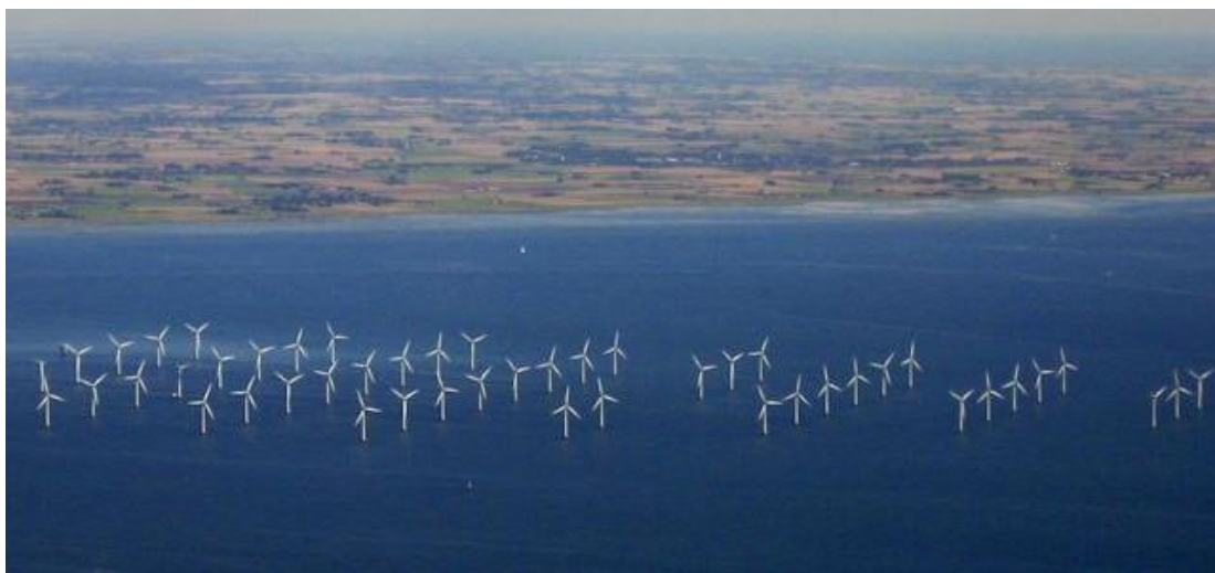
SI.3.2. Priobalna vjetroelektrana Lillgrund (Švedska) puštena u pogon 2008. Koristi 48 vjetroagregata SWT 2.3-93. Električnom energijom opskrbljuje 60 tisuća kućanstava.[8]
