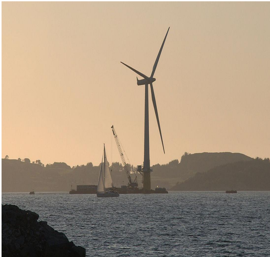
Sl.3.3. Prvi veći plutajući vjetroagregat Hywind, koji je sklopljen u Stavangeru (Norveška), prije nego je postavljen u Sjevernom moru.
