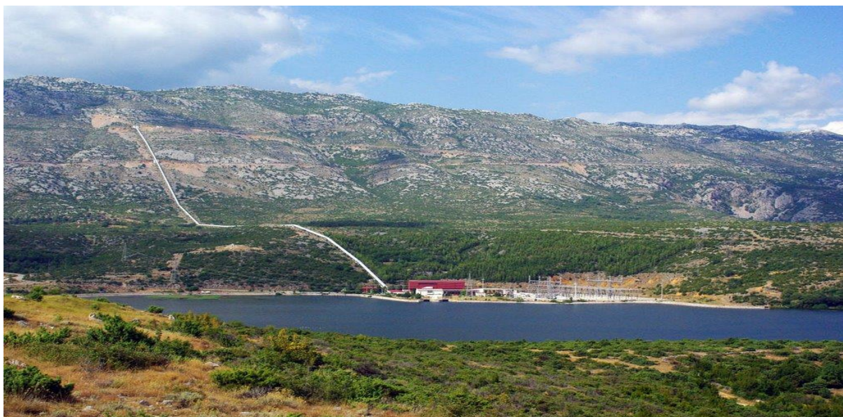
Slika 3.4. Pumpno-akumulacijska hidroelektrana RHE Velebit
