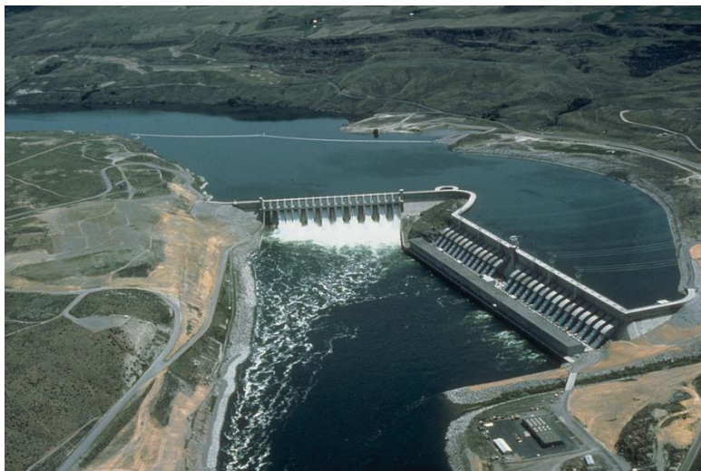
Slika 2.1. Protočna hidroelektrana “Chief Joseph Dam“
