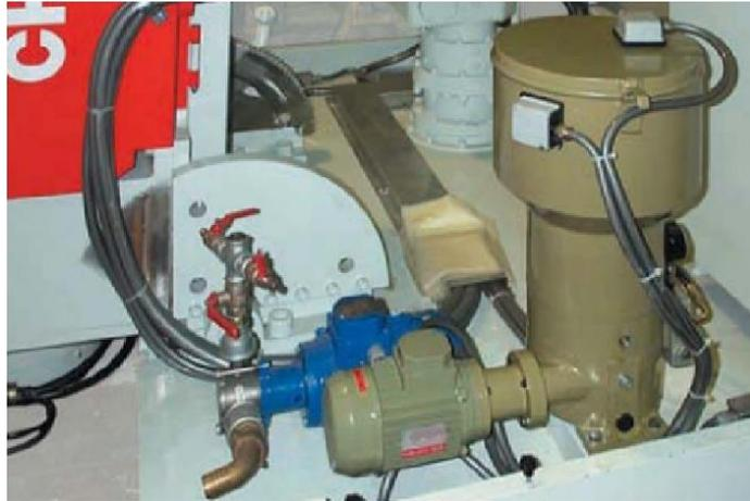
**Slika 5.5.** Motor za podmazivanje
