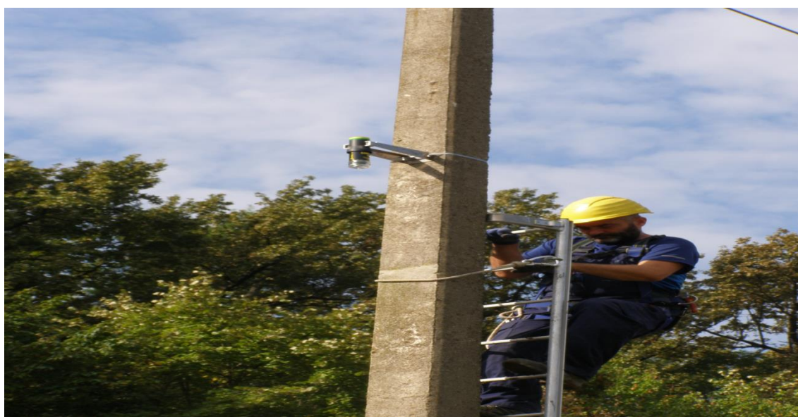
Slika 3.11. Monter prilikom montaže indikatora LineTroll 111K na betonski stup na vodnom polju ZIB
