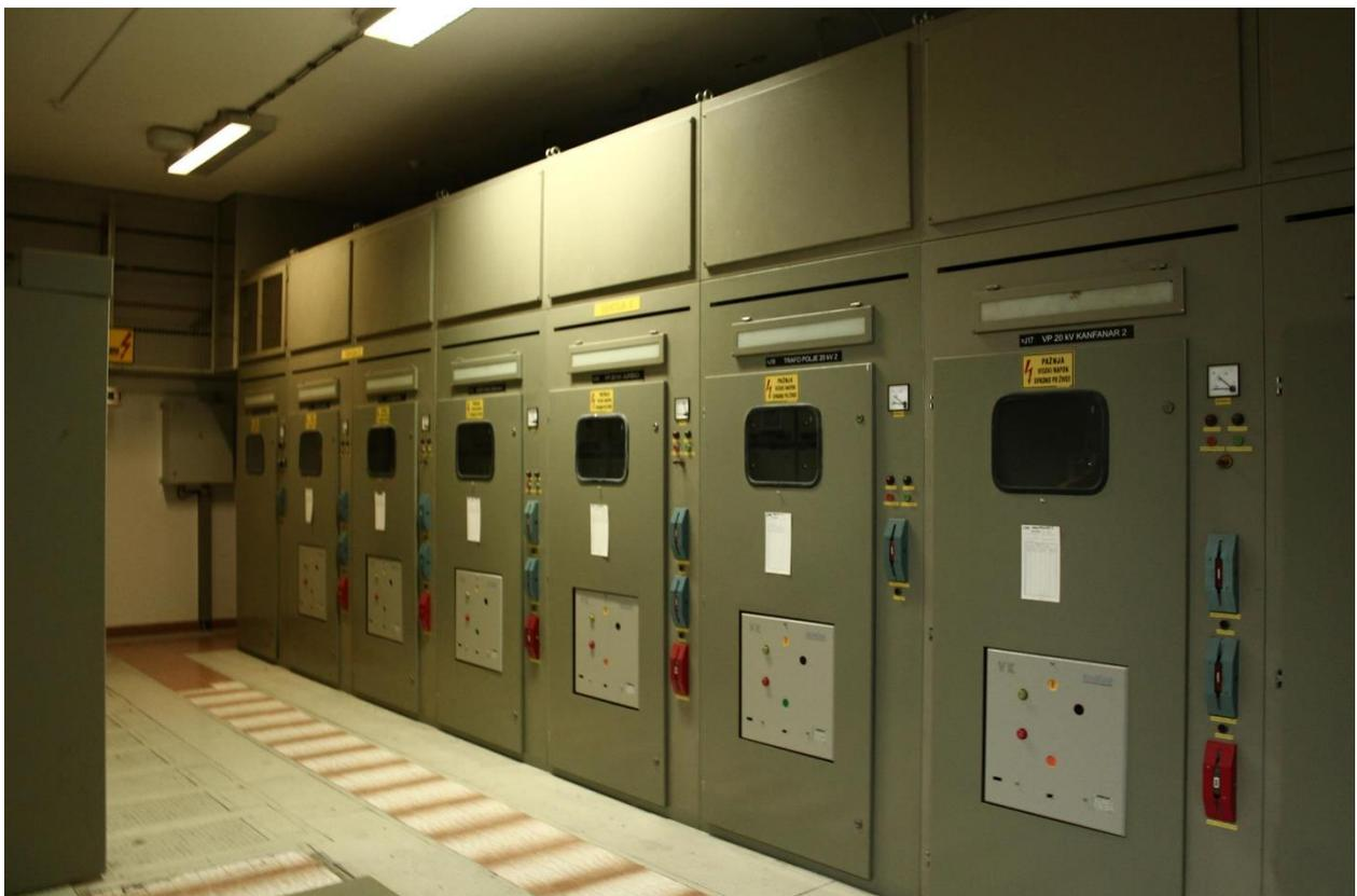
Slika 5.4. Odvojena vodna polja sa prekidačima na 20kV naponu u TS Vinčent
