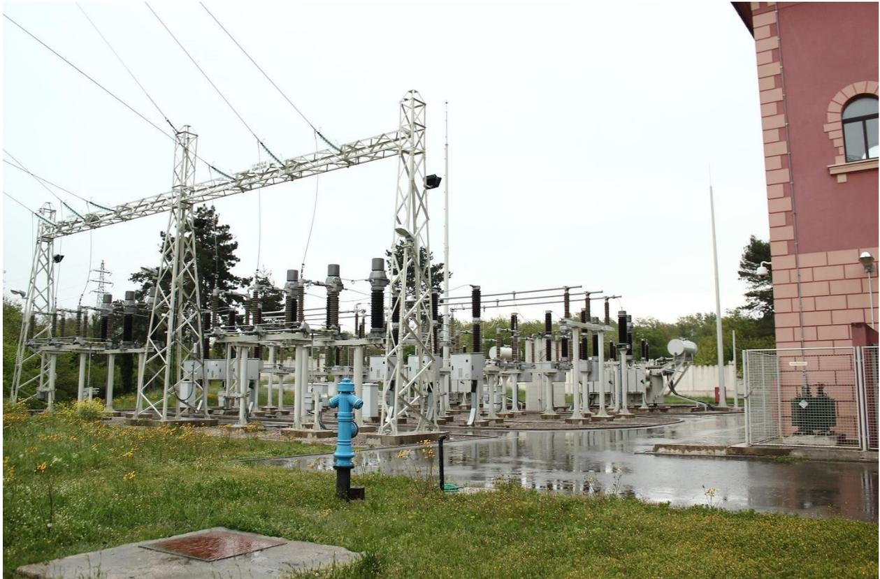
Slika 5.2. Trafostanica Vinčent 110/20kV snage 40MVA
