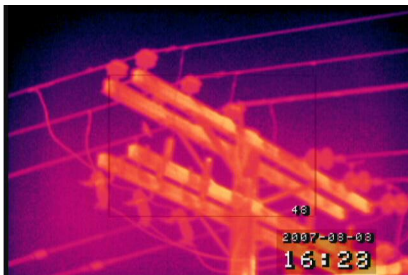
Slika 8.5. Prikaz dalekovoda infracrvenom kamerom u infracrvenim bojama
