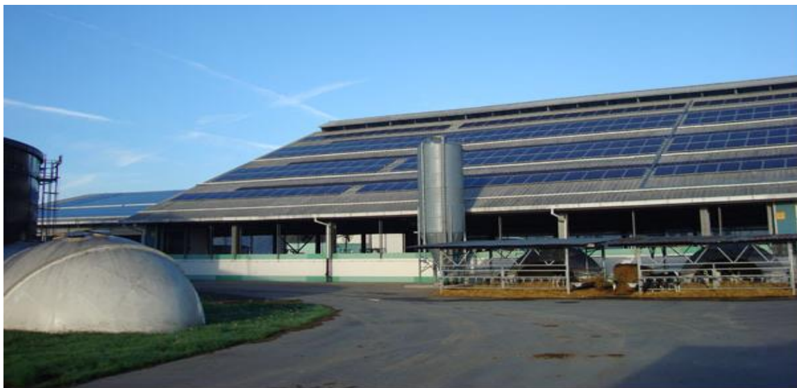
Slika 3.4. Fotonaponska elektrana Topolik.
