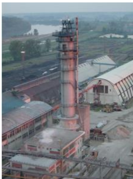
Slika 3.9. Postrojenje za pečenje vapnenca (preuzeto iz [2])
