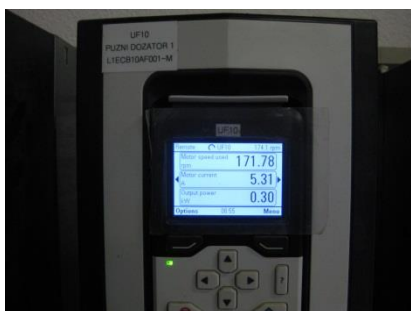
Slika 3.47. Regulator pužnog dozatora 1
