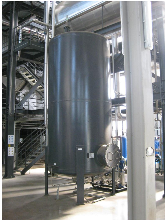
Slika 3.38. Napojni spremnik
