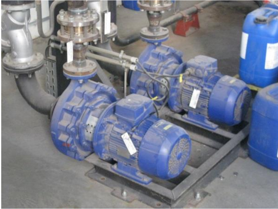
Slika 3.31. Pumpe kondenzata
