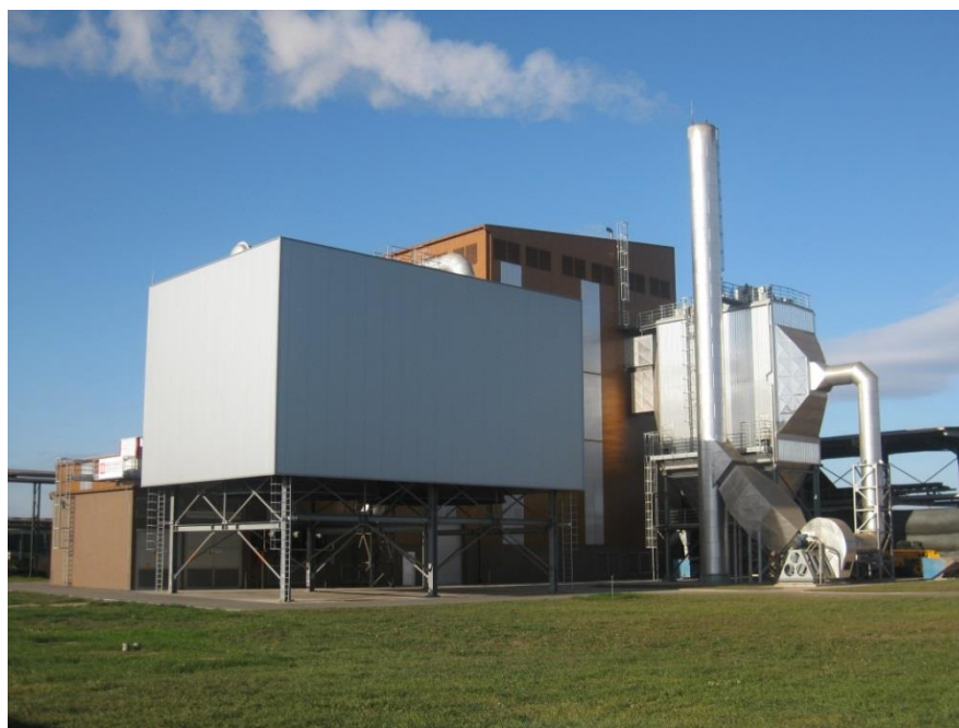
Slika 2.3. Elektrana na biomasu " Slavonija OIE"
