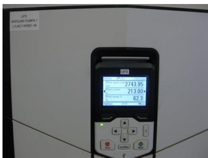
Slika 3.54. Regulator za napojnu pumpu 1
