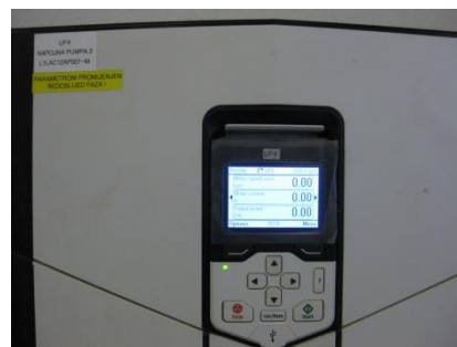
Slika 3.55. Regulator za napojnu pumpu 2
