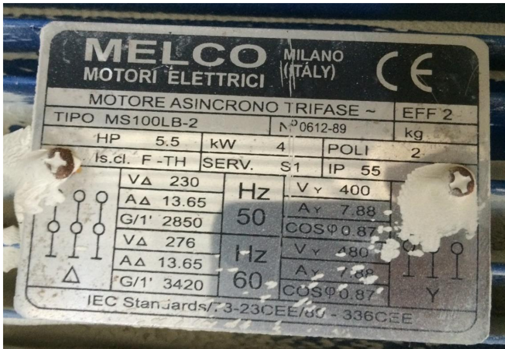
Slika 3.21. Natpisna pločica motora otprašivača
