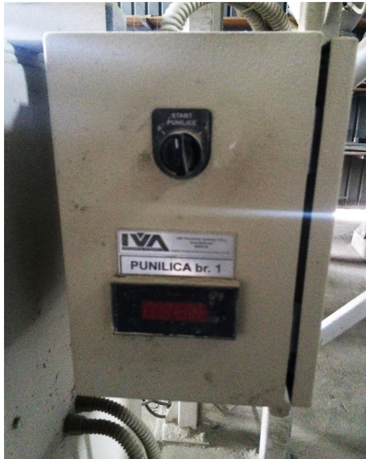
Slika 3.30. Upravljački pult punilice
