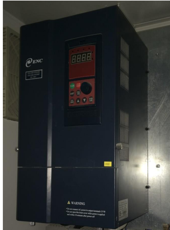
Slika 3.38. Frekvencijski pretvarač
