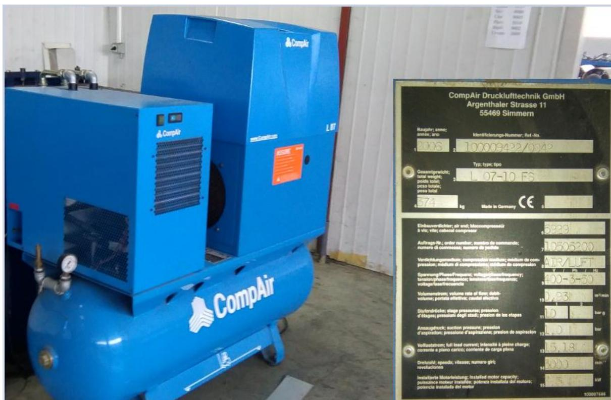
Slika 3.24. Kompresijska stanica i kada uvećane natpisne pločice
