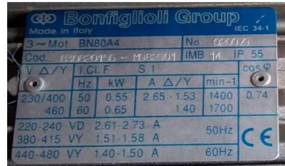
**Slika 3.37.** Natpisna pločica motora na slikama 3.38. i 3.39.
