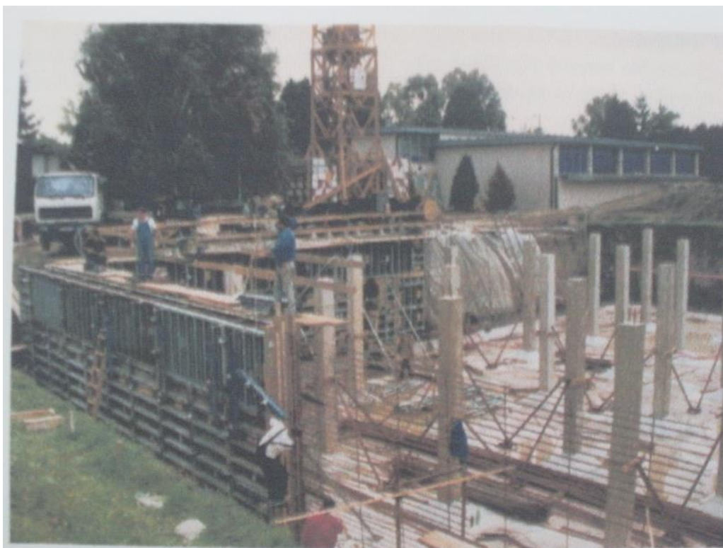
Slika 3.1. Vodosprema pitke vode 2500 m 3
