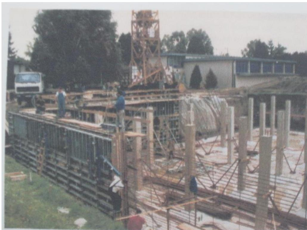
**Slika 3.1.** Vodosprema pitke vode  $2500 \text{ m}^3$
