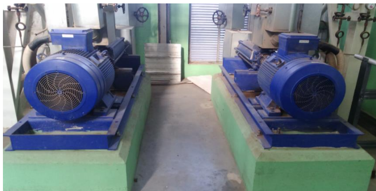
Slika 5.8. Napojne pumpe
