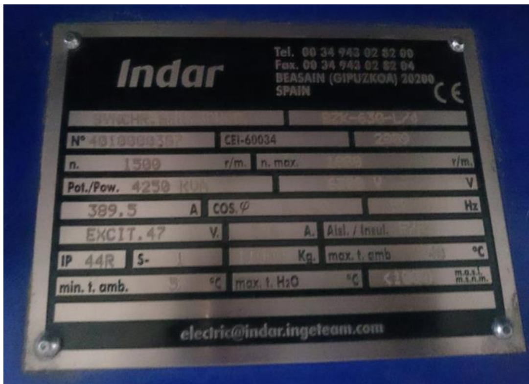
Slika 5.14. Natpisna pločica generatora
