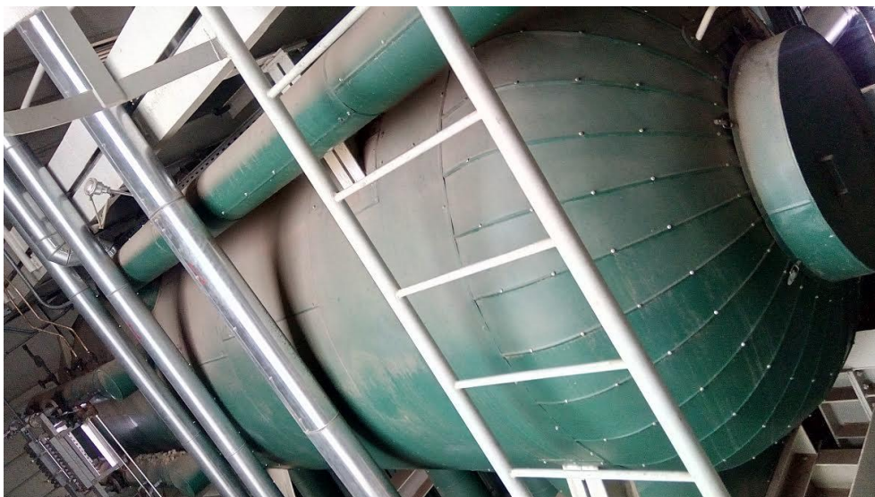
Slika 5.7. Bubanj kotla
