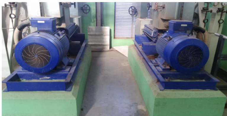
Slika 5.8. Napojne pumpe
