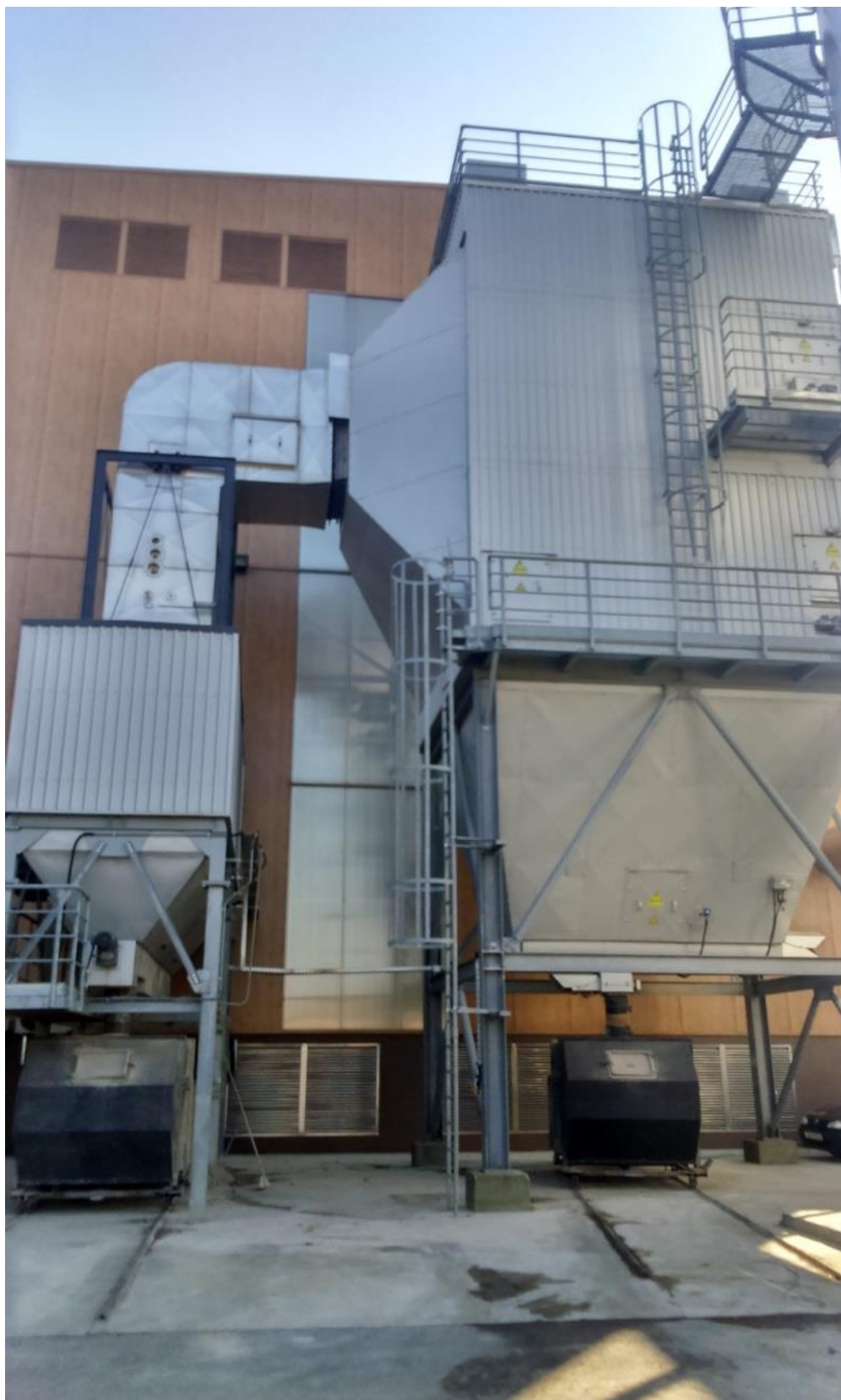
Slika 5.22. Multiciklon i filter
