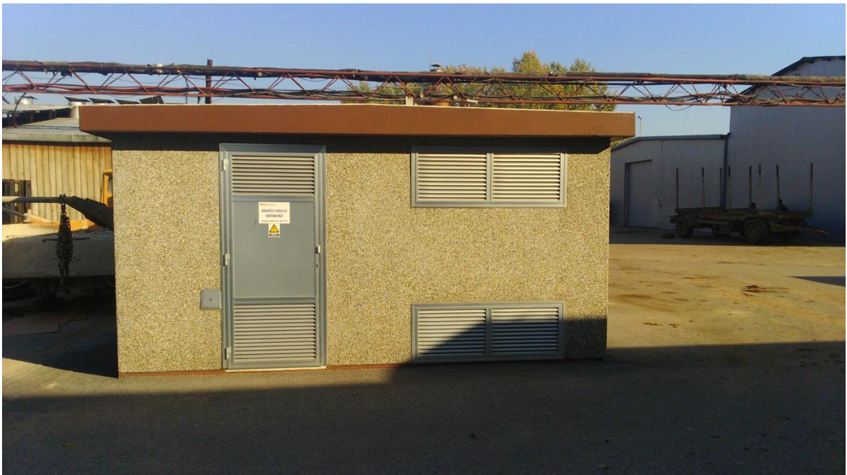
Slika 5.17. Rasklopište
