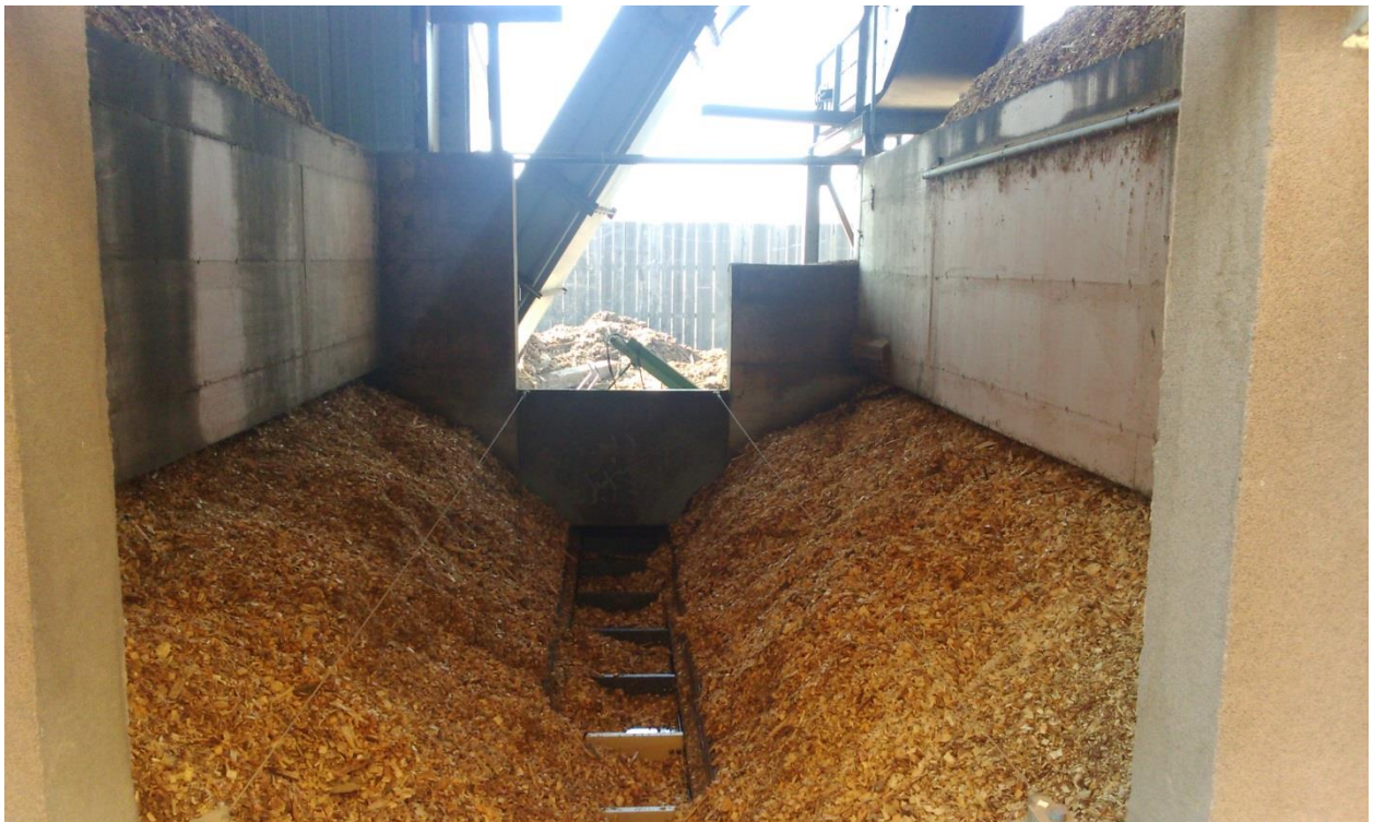
Slika 5.2. Dnevni spremnik
