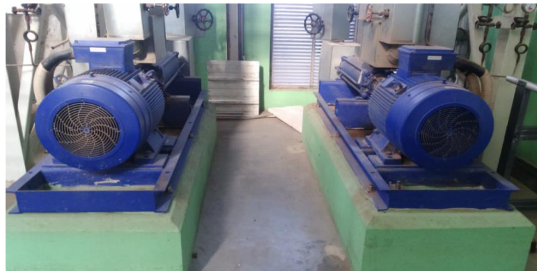
Slika 5.8. Napojne pumpe
