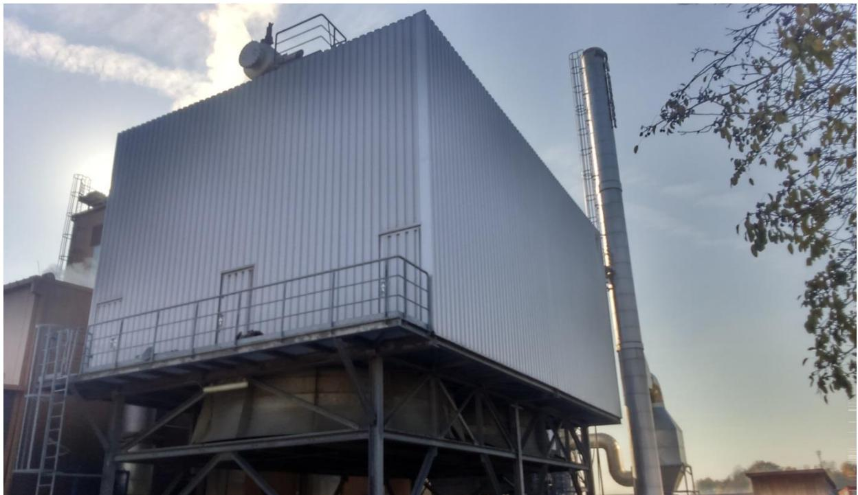
**Slika 5.11.** Vanjski izgled zračnog kondenzatora
