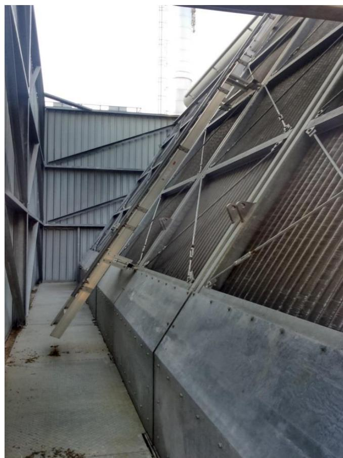
**Slika 5.12.** Unutrašnji dio kondenzatora
