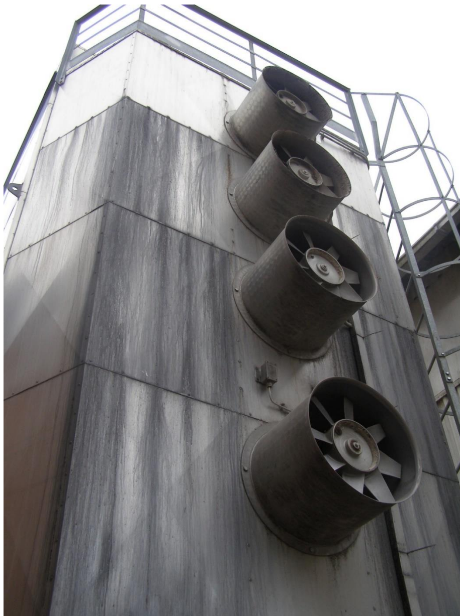
Slika 5.11. Ventilatori sušare
