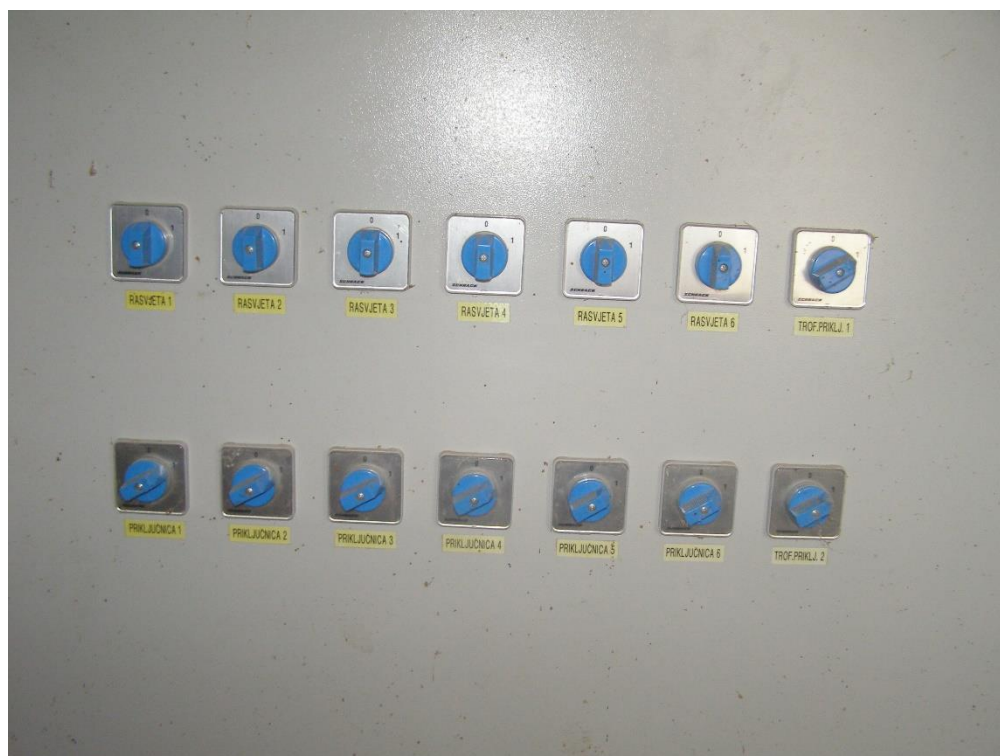
Slika 5.19. Sklopke za rasvjetu
