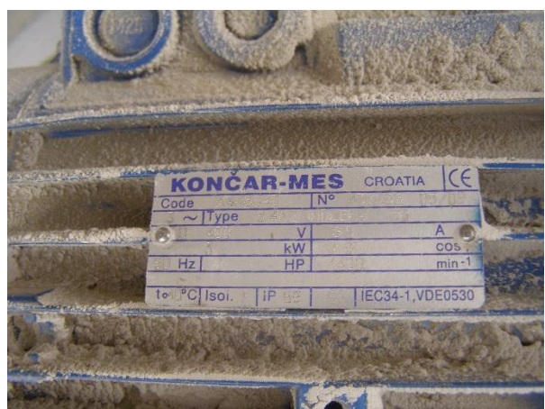
Slika 5.4. Natpisna pločica motora
