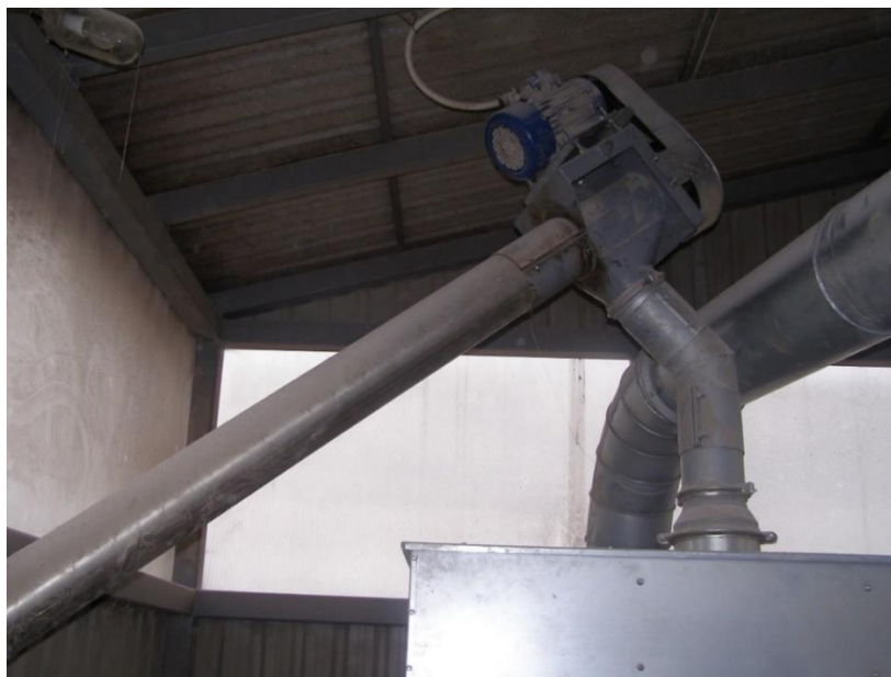
Slika 4.2. Pužni transporter s pogonskim motorom
