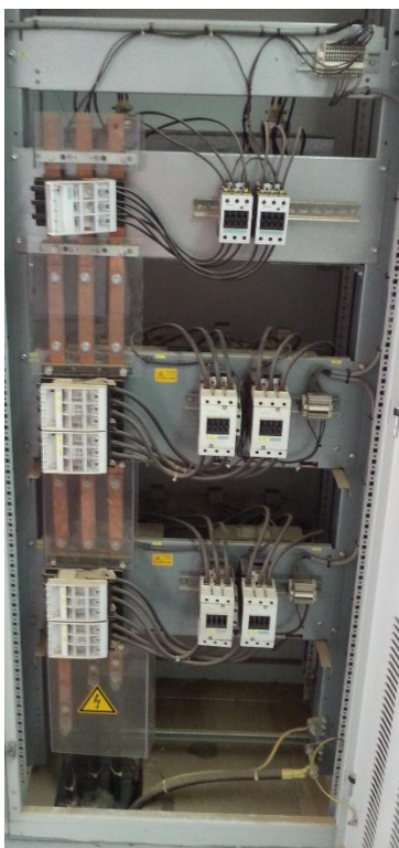
Slika 5.22. Ormar za kompenzaciju jalove snage 1
