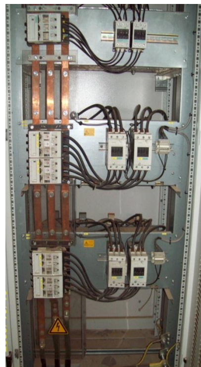
Slika 5.21. Napojno polje kompenzacije za transformator 2
