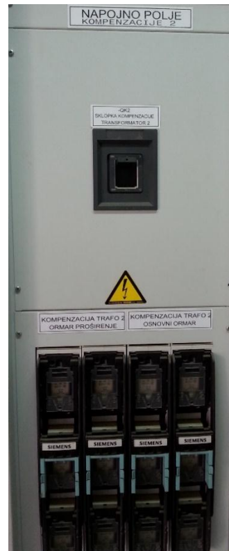
Slika 5.21. Napojno polje kompenzacije za transformator 2
