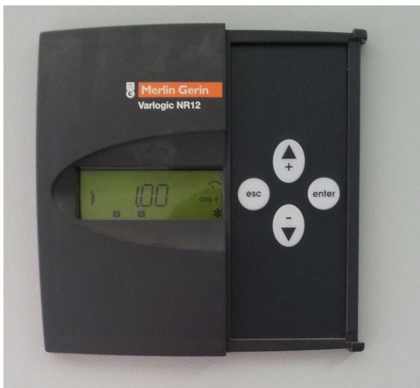
Slika 5.18. Digitalni displej prikazuje faktor snage
