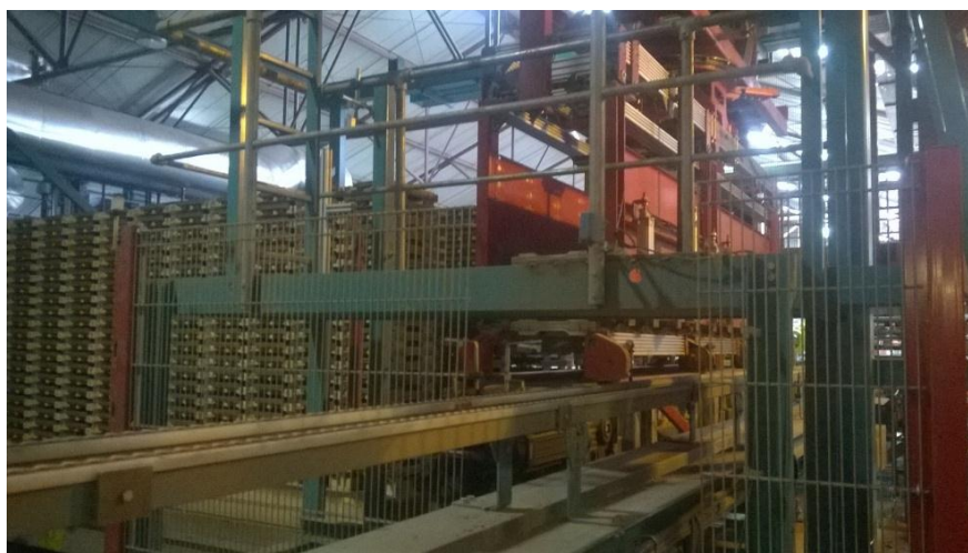
Slika 4.21. Crijeplj se utovara na vagonne
