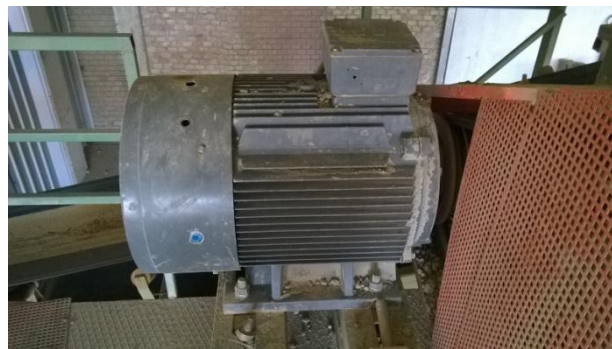
Slika 4.15. Asinkroni motor 2. valjka ispred prese
