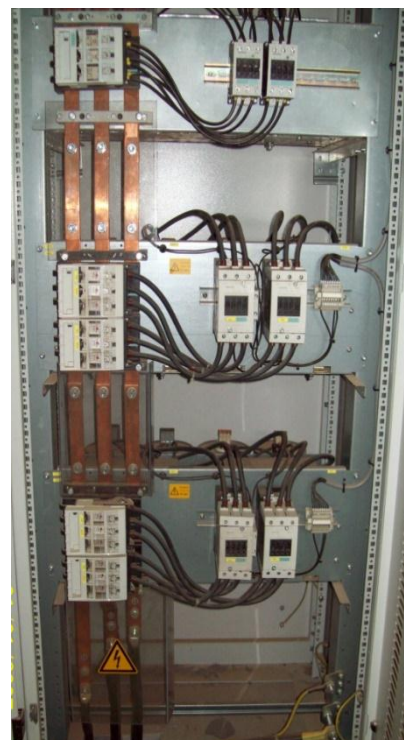
Slika 5.21. Napojno polje kompenzacije za transformator 2
