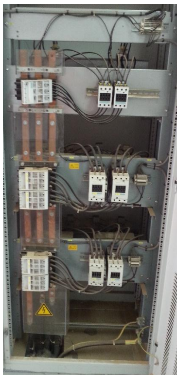
Slika 5.22. Ormar za kompenzaciju jalove snage 1
