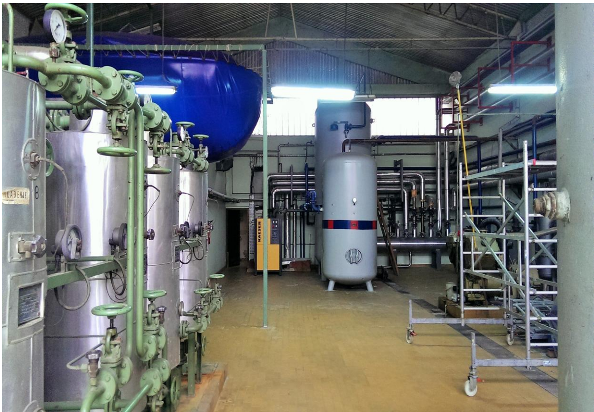
Slika 4.4. Pogon za kružni proces ugljikovog dioksida (CO 2 )
