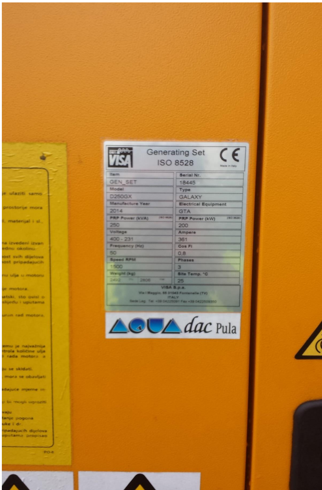
Slika 7.7. Natpisna pločica pomoćnog generatora [5]
