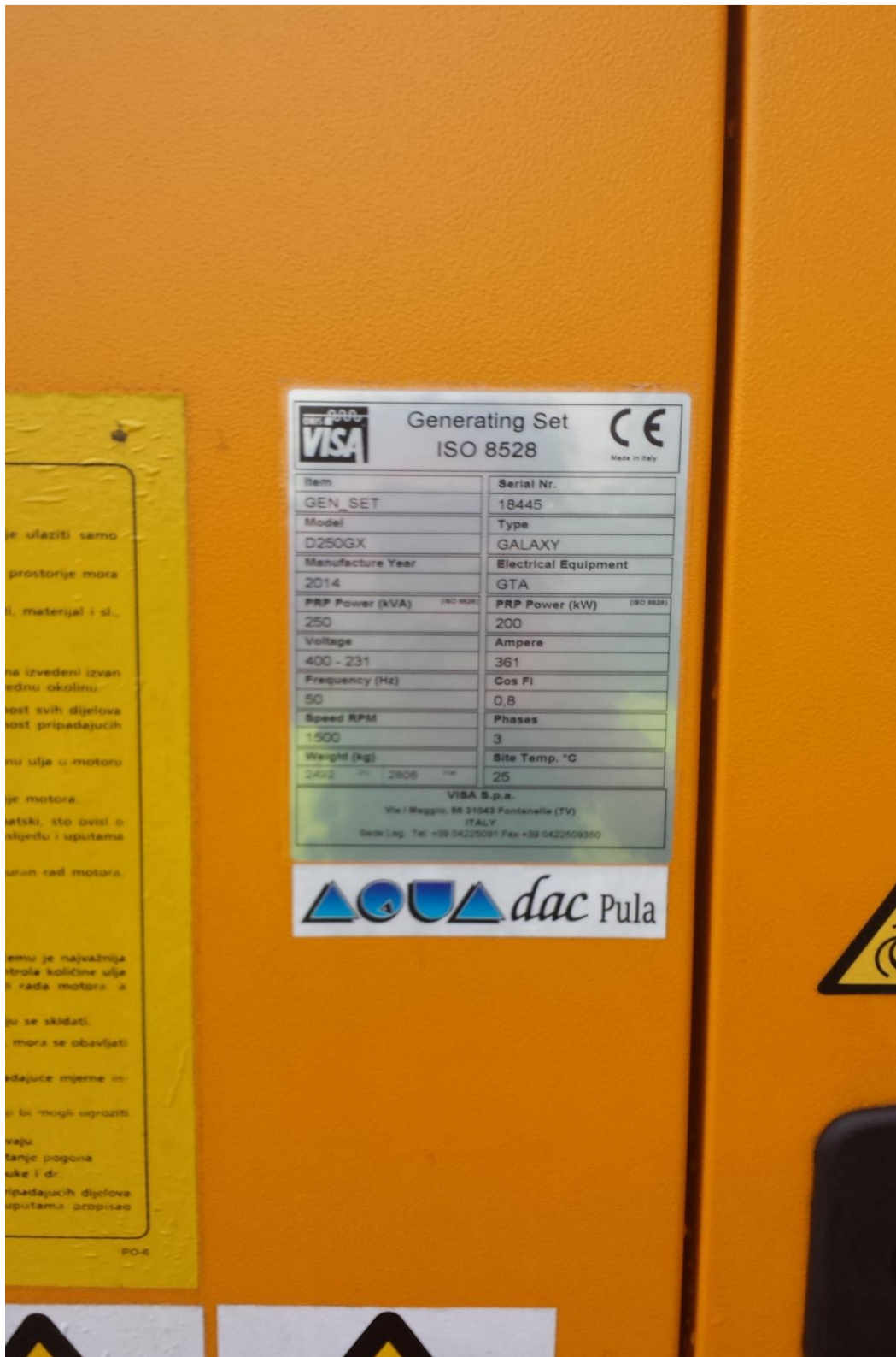
Slika 7.7. Natpisna pločica pomoćnog generatora [5]
