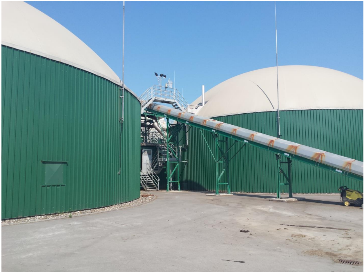
Slika 5.11. Dva fermentora (kupole) i trakasti transporter [fotografirano 8. lipnja 2015.]
