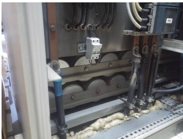
Slika 2.6. Prikaz kompezacijskih baterija
