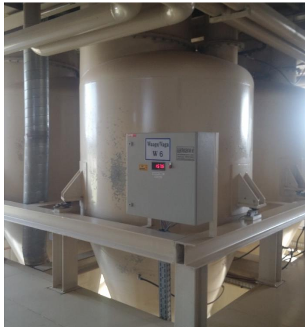
Slika 3.8. Prikaz vage 6 (vage za veće točnosti)
