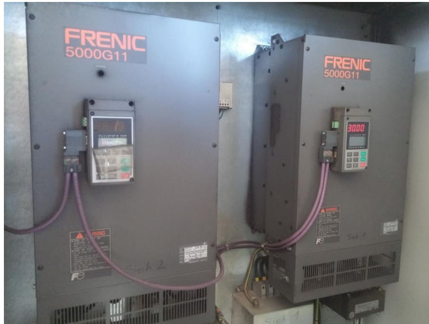
Slika 2.9. Prikaz frekvencijskih pretvarača
