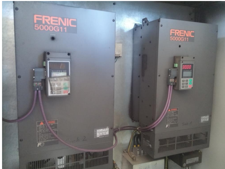
Slika 2.9. Prikaz frekvencijskih pretvarača
