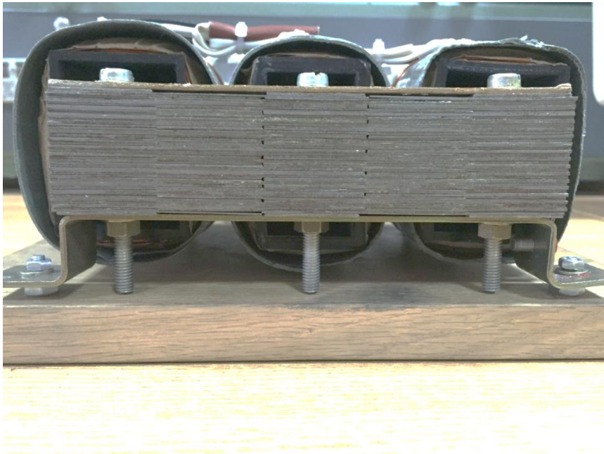
Sl. 2.16. Pogled na novo namotani transformator iz perspektive pogleda na zračne raspore
