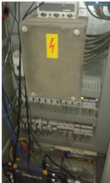
Slika 4.10. Smještaj instrumenta u razvodnom ormaru
