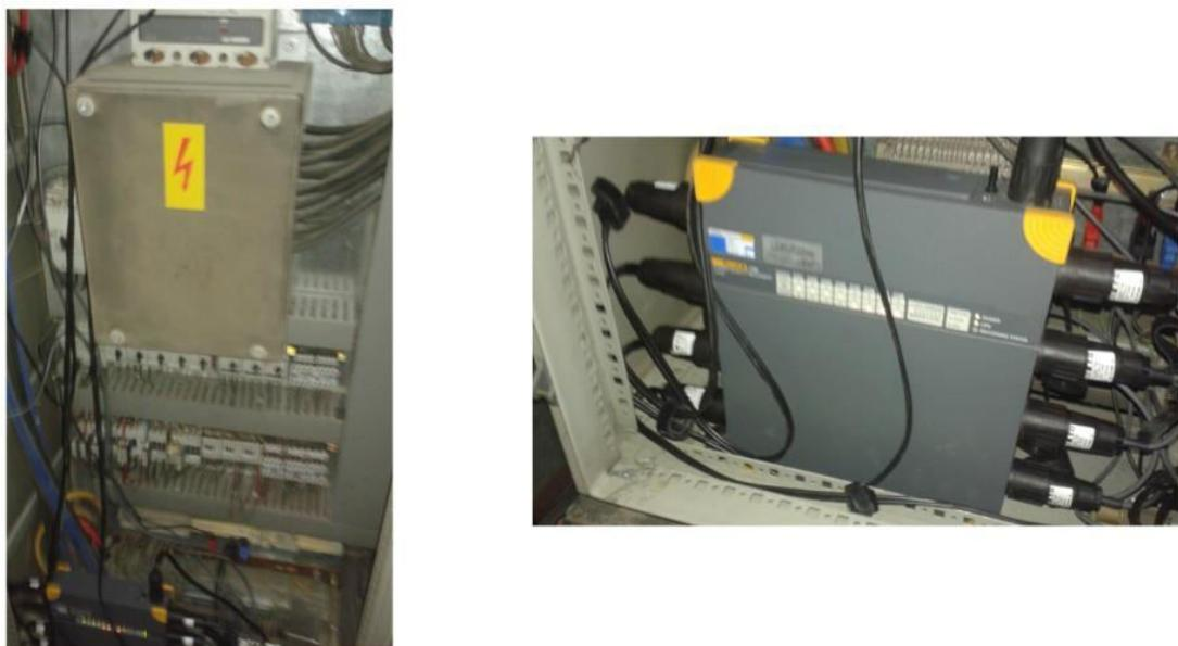
**Slika 4.10.** Smještaj instrumenta u razvodnom ormaru
