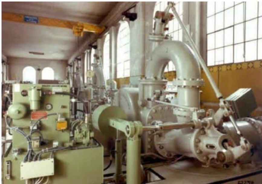
Sl. 4.1. Modernizirani sustav upravljanja (1986.) u Burglauenen (Jungfrauoch-Bahn, Švicarska), sa dvije Peltonove jedinice po 1 MW. [9]
