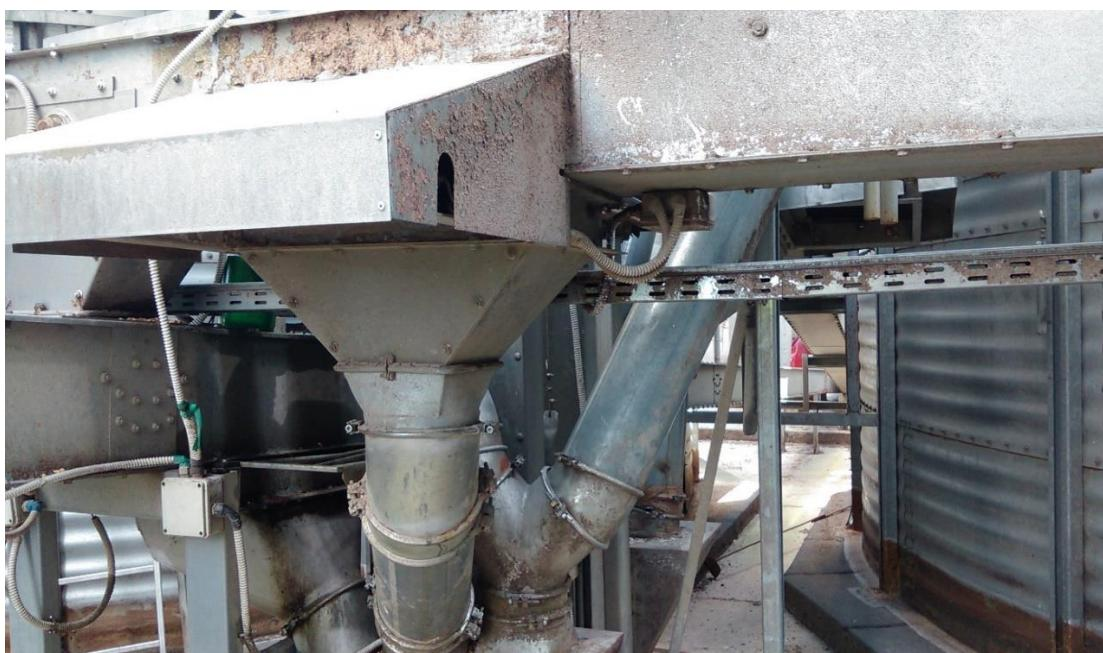
**Slika 2.13.** Usmjeritelj žitarica u čelije silosa
