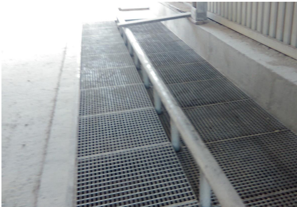
Slika 2.6. Usipni koš za istovar žitarice
