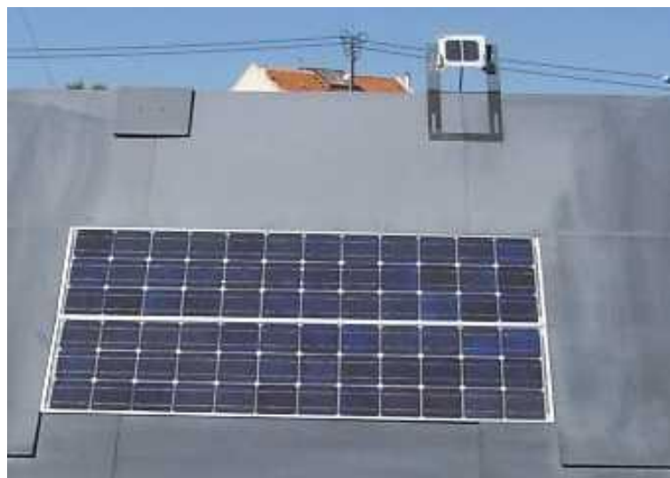
Slika 2.6. Fotonaponski sustav formiran od dva monokristalna silicijska fotonaponska modula spojena u seriju.
