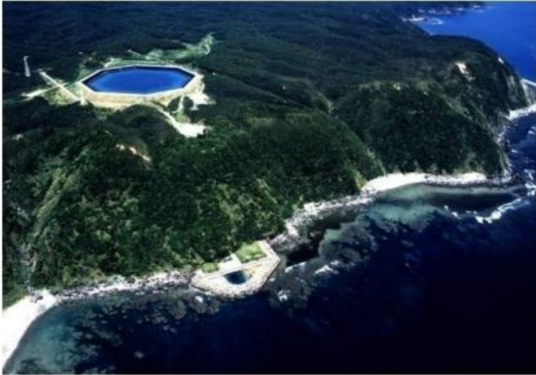
Slika 3.3 Yanbaru 30MW crpno-akumulacijska hidroelektrana [4]
