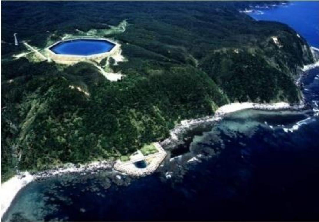
**Slika 3.3** Yanbaru 30MW crpno-akumulacijska hidroelektrana [4]
