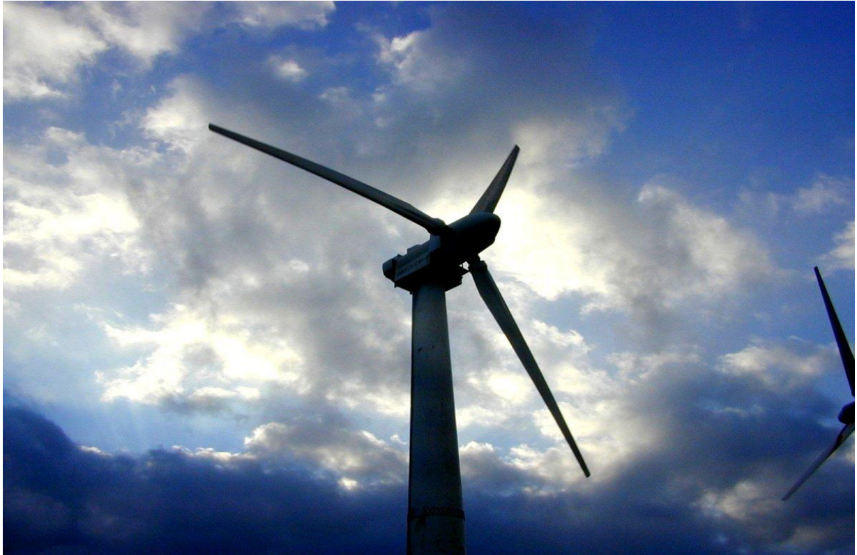
Slika 2.2. Vjetroturbina s vodoravnom osi i trima lopaticama [14]
