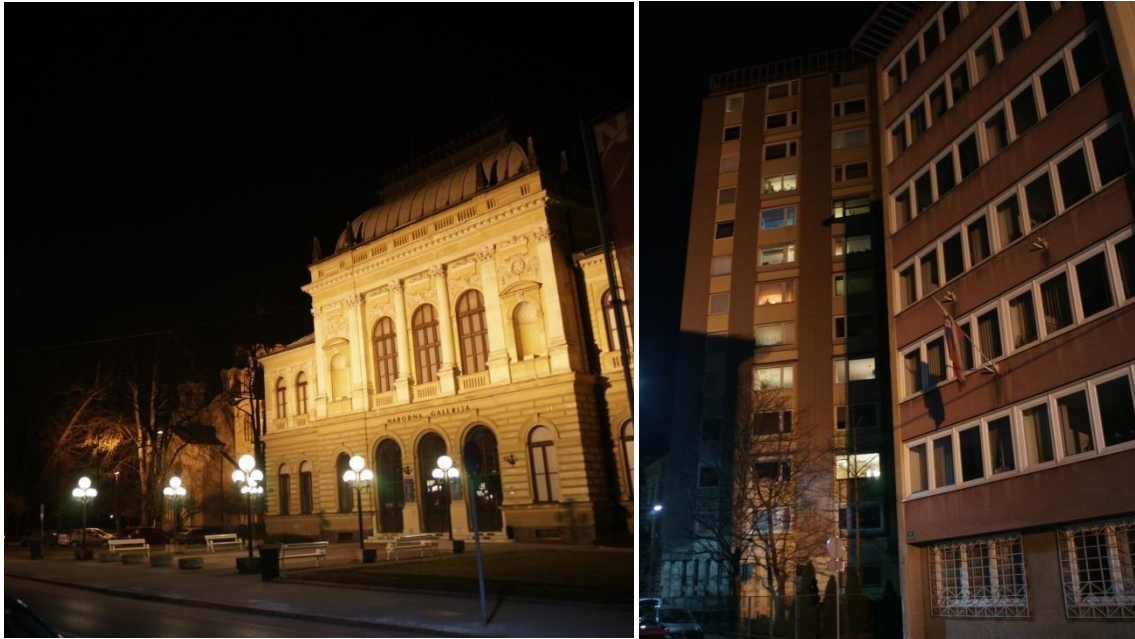
Slika 6.2.3. Primjer propuštanja svjetlosti rasvjete fasade [8]
