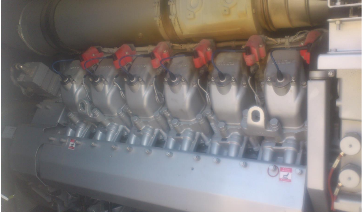
Slika 3. Plinski motor GE Jenbacher [2]
