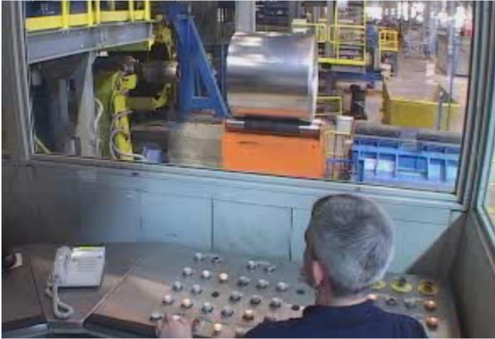
Slika 3.3. Nadzor sustava preko kontrolnog panela
