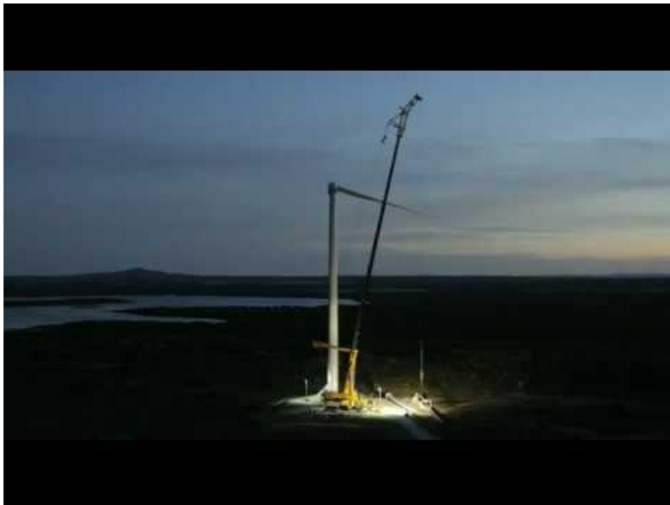
Slika 4.16: Postavljanje vjetroelektrane V90-3.0 MW[27]
