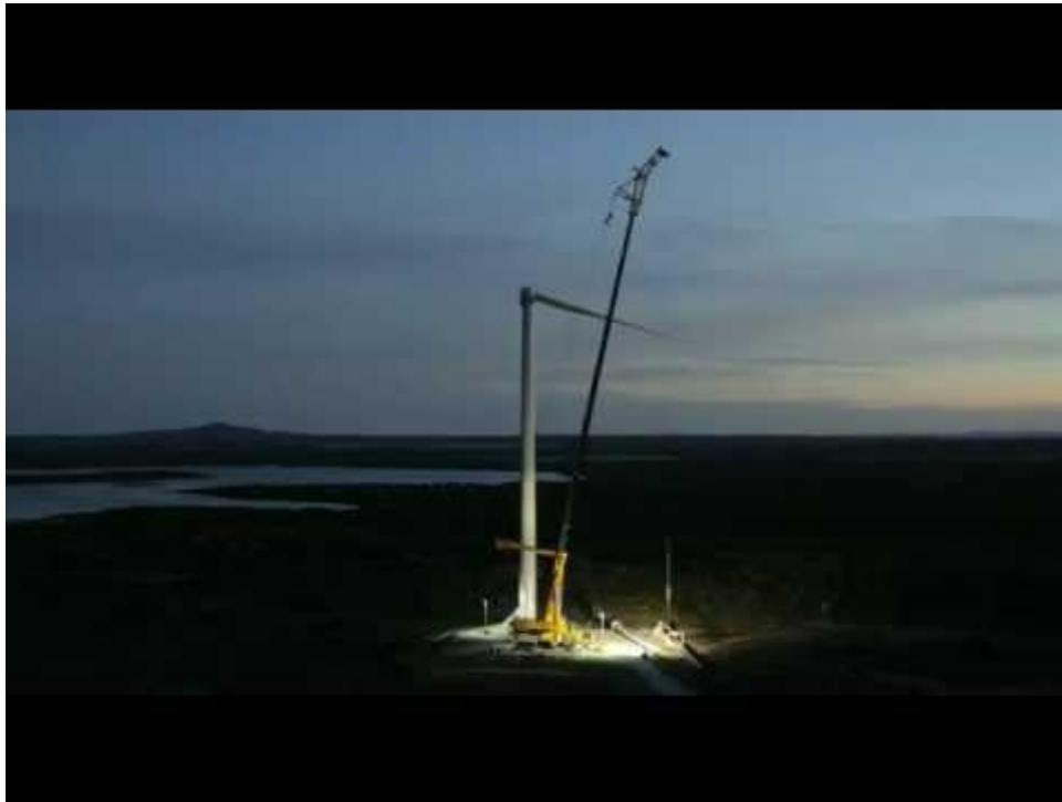
Slika 4.16: Postavljanje vjetroelektrane V90-3.0 MW[27]
