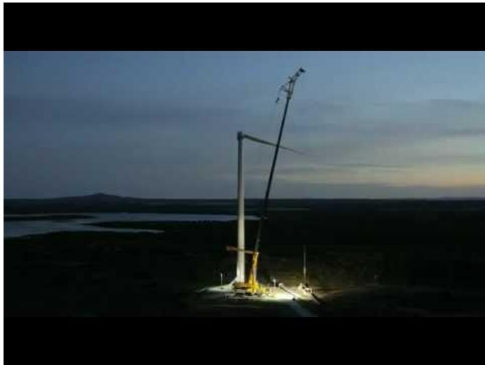
**Slika 4.16:** Postavljanje vjetroelektrane V90-3.0 MW[27]
