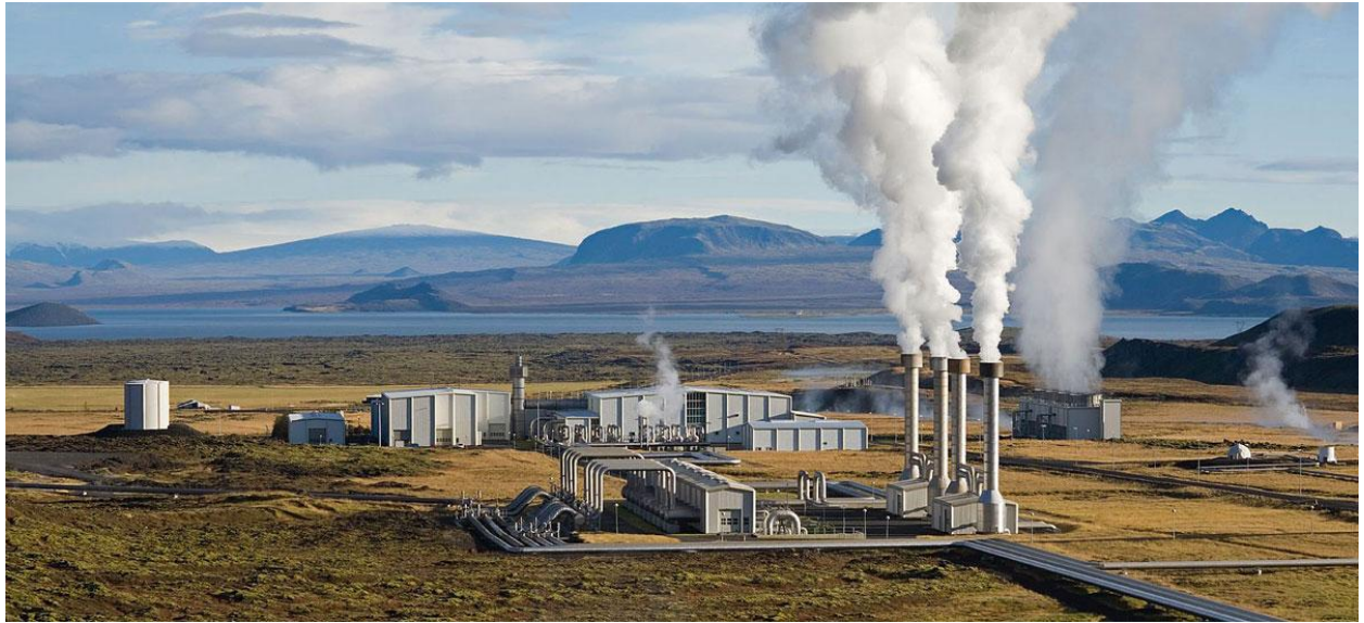
Sl. 4.1 Geotermalna elektrana Nesjavellir, Island [5]
