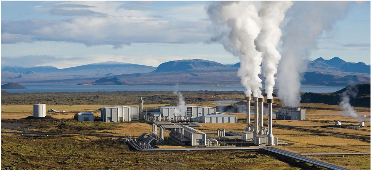
Sl. 4.1 Geotermalna elektrana Nesjavellir, Island [5]
