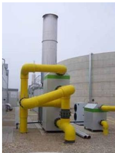
Slika 2.16. Izgled baklje za izgaranje bioplina [4]
